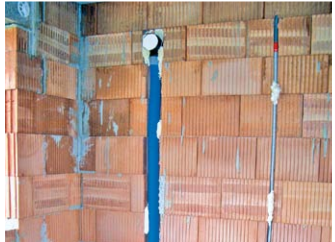
Befestigung des Luftverteilschlauches und der Saugnische im Mauer-schlitz mit Montageschaum
