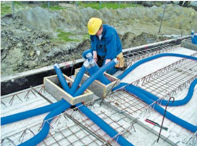
Einfache Montage auf der Fertigteildecke zum Einbetonieren in der Rohdecke
