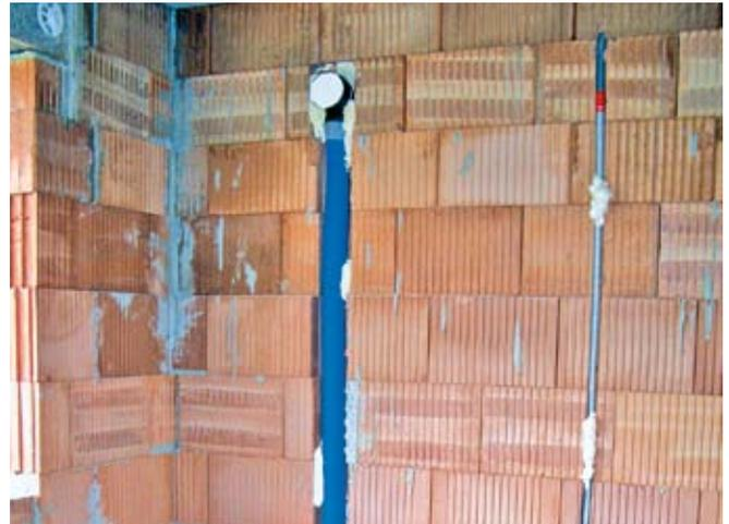
Befestigung des Luftverteilschlauches und der Saugnische im Mauer-schlitz mit Montageschaum
