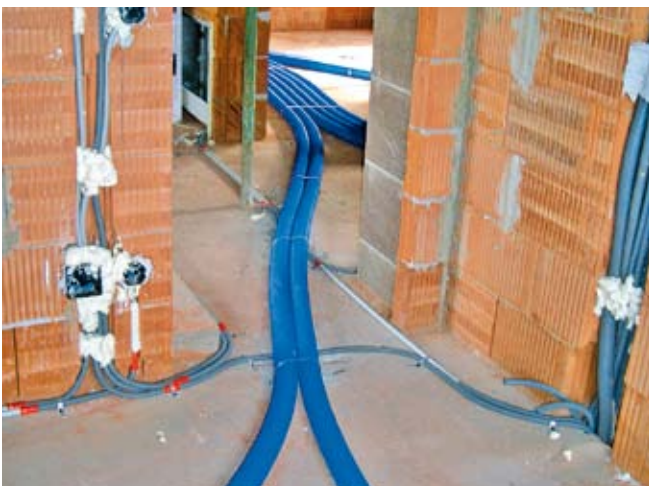
Ein weiteres Verlegebeispiel im Fußbodenaufbau
